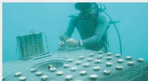
マリンブロック®へのサンゴ着床具設置状況
