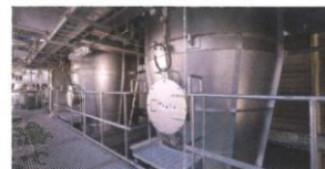
⑨ 炭化物ホッパ(20m 2 ×2基+25m 2 ) Carbide hopper (20 m 2 × 2 units, 25 m 2 × 1 unit) 下水汚泥炭化燃料(炭化物)を一時貯留します。 Stores carbonized sewage sludge fuel (carbide) temporarily.
