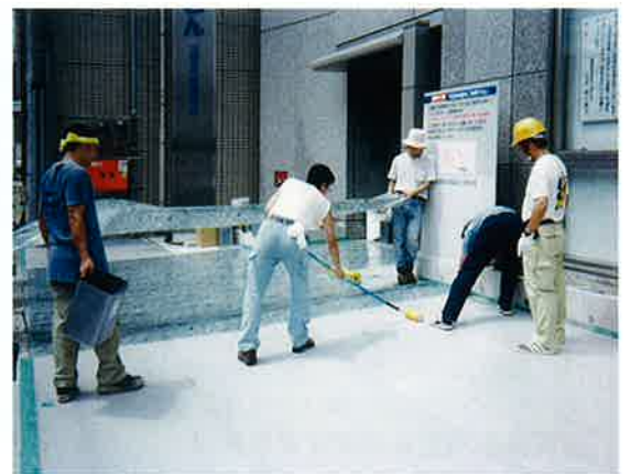
金融機関の駐車スペースをコンクリから大理石調へ
